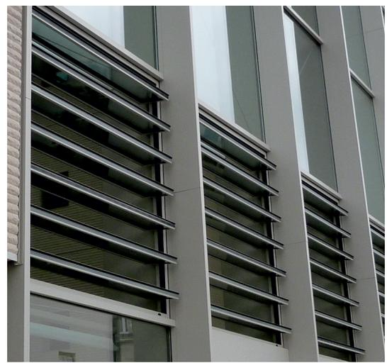
Le châssis de façade à ventelles, de type **FLW 40** est composé de lames à rupture de pont thermique.
