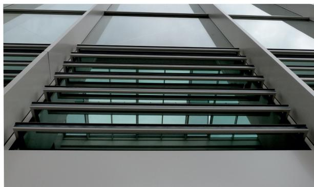
Le châssis de façade à ventelles, de type **FLW 32** est composé de lames à rupture de pont thermique.
